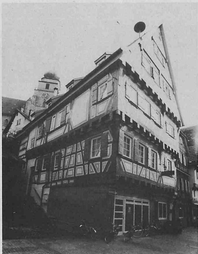
ALTSTADT-SANIERUNG in Herrenberg
