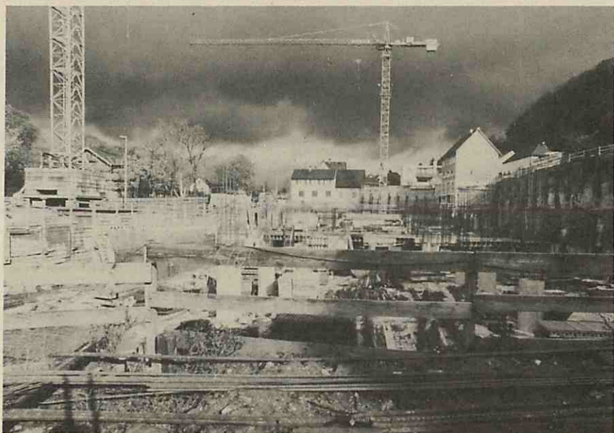
Die Großbaustelle "NUFRINGER TOR" unter dem Gewitterhimmel
