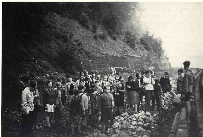
Damals war der Alb-Aufstieg der Bundesautobahn noch Baustelle!
