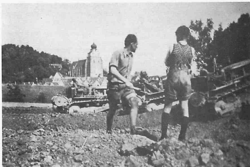
9. Juni 1952: Baubeginn des Herrenberger Stadions
