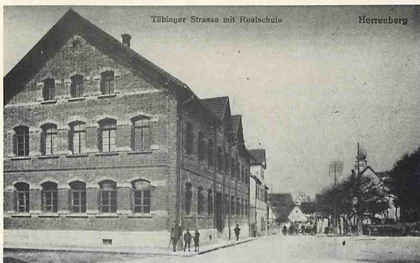
Realschule an der Tübinger Straße. Erbaut 1899 / 1900.
