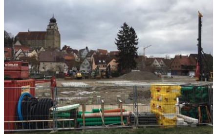
(Baubeginn © S. Dierberger)
