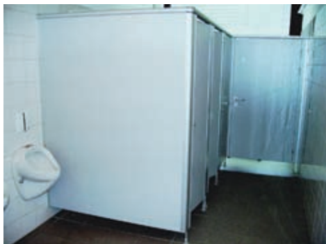
Totalsaniert: Die Toiletten
