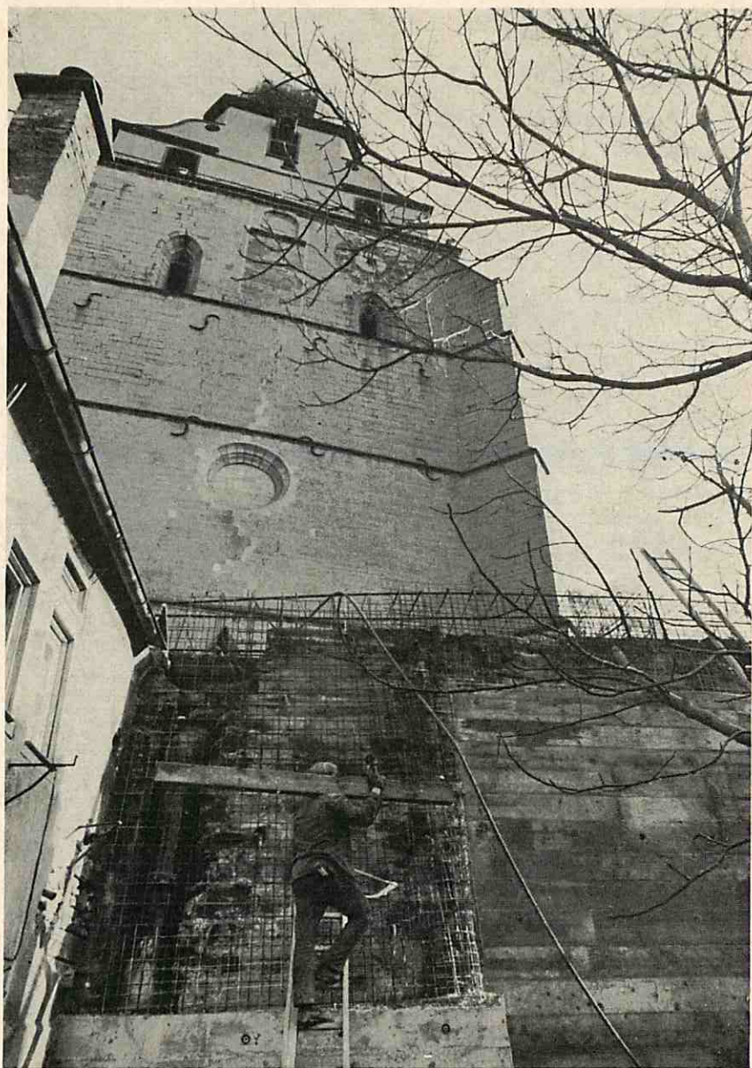
Die neue Stützmauer für den westlichen Vorplatz ist zwischen dem Haus Haar (links) und dem ehemals Straßenwart Ruthardt'schen Haus an der mittleren der drei Kirchentrepfen im Aufbau begriffen. Der Nußbaum, dessen Äste ins Bild ragen, gehört zu dem Haus von Zimmermann Braun (jetzt Probst).
